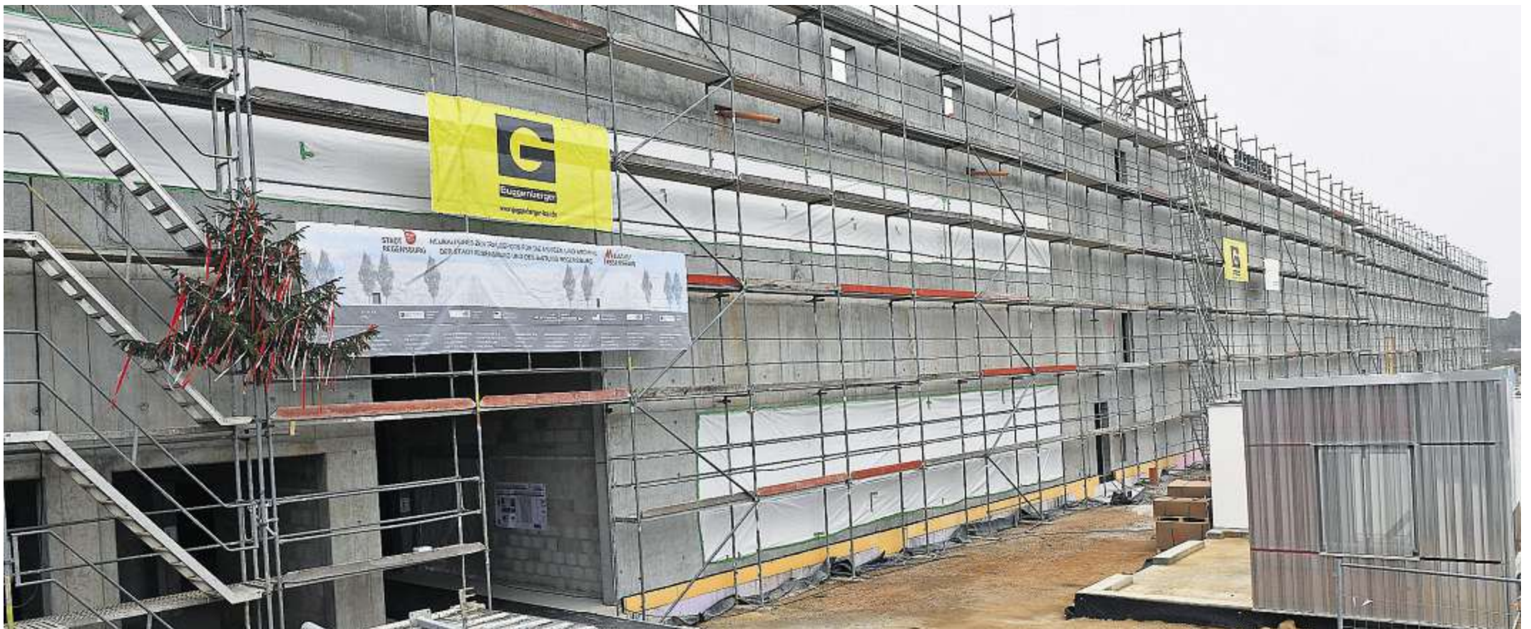
Ein ellenlanges Gebäude: der Rohbau des neuen zentralen Depot- und Magazingebäudes für die Museen der Stadt Regensburg und die Kunstsammlungen des Bistums Regensburg. Obendrein wird es das Bischöfliche Zentralarchiv und das Stadtarchiv beherbergen. FOTOS: TINO LEX
